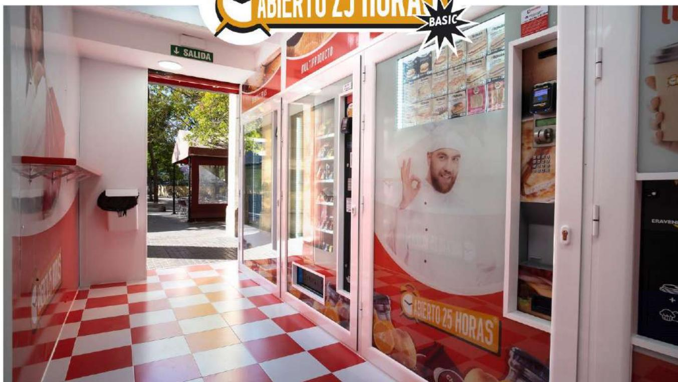
En la foto ejemplo de protección de cristal blindado de 5+5, con perfiles de aluminio, cerraduras y bisagras de seguridad opcionales. Precio por puerta 1.590 euros (IVA no incluido), fabricación e instalación.
